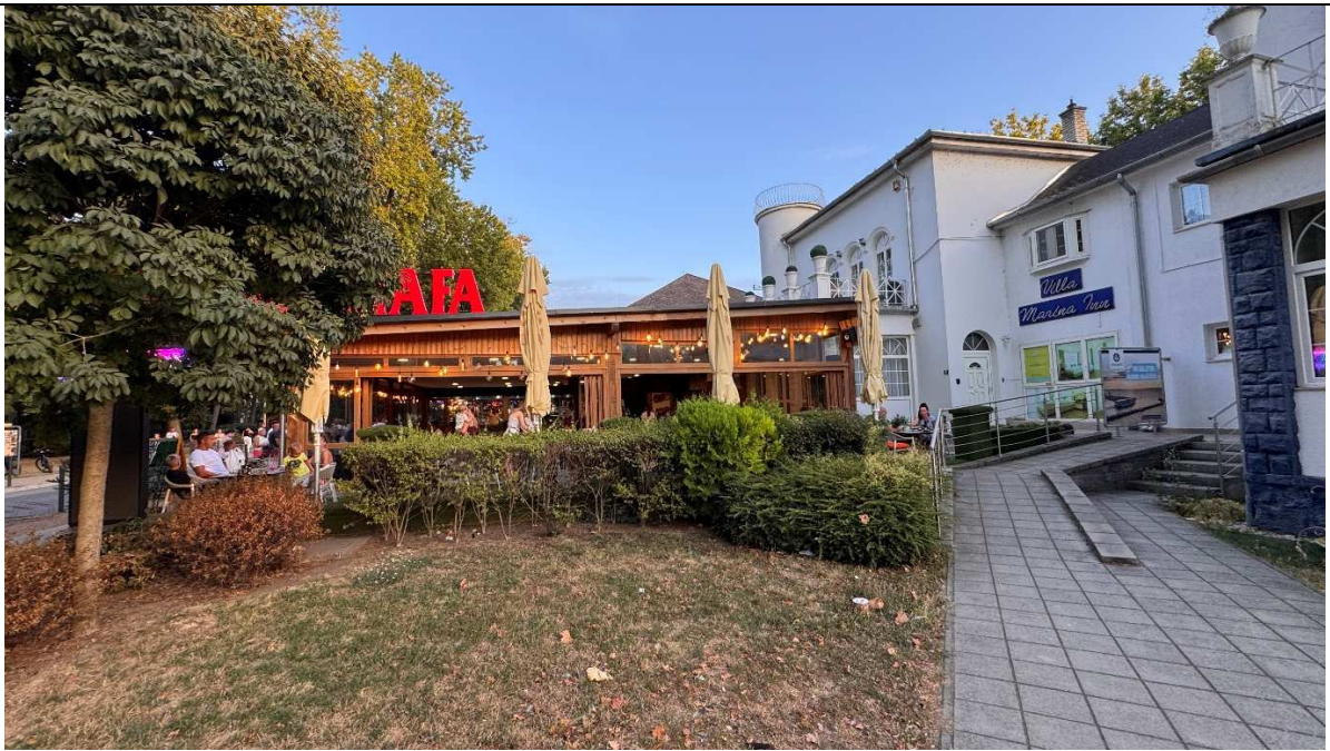
Déli épület, keleti homlokzat a Mártírok útjáról
