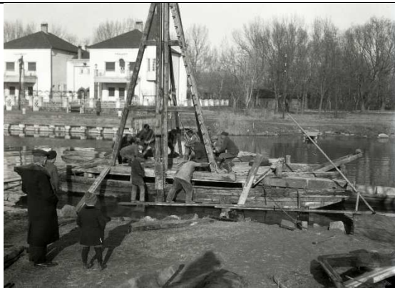
1920. Cölöpözés a siófoki kikötőben a Kikötőfelügyelőség telepi és szolgálati lakásainál (Forrás: Fortepan, képszám 183433)
