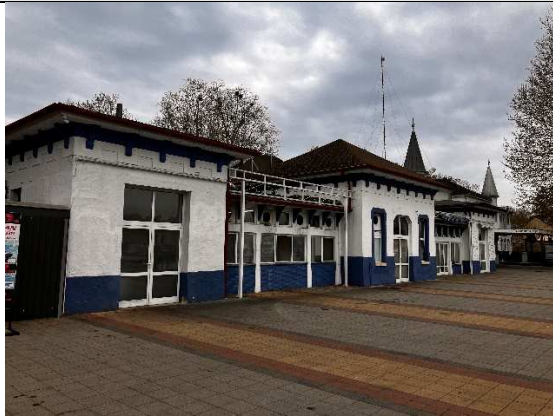
Nyugati homlokzat a Sió felől_1
