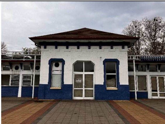
Nyugati homlokzat a Sió felől_3
