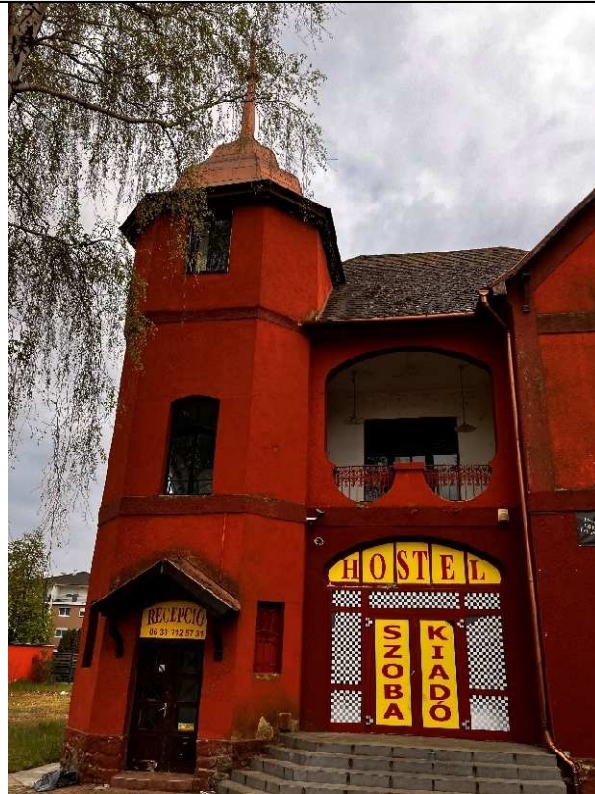
Északi homlokzat – torony és a bejárat a loggiával
