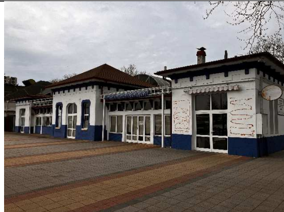
Nyugati homlokzat a Sió felől_2
