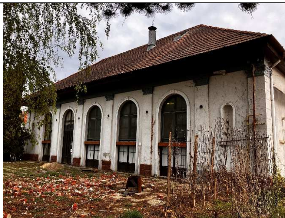
Bálterem belső homlokzata
