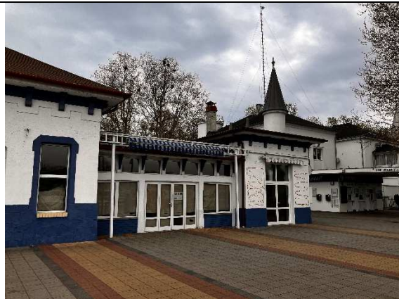
Nyugati homlokzat a Sió felől_4
