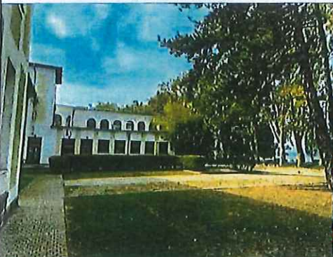
Az épület előtti terület (északi oldal)
