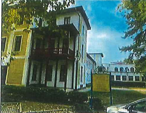
Az épület kívülről
