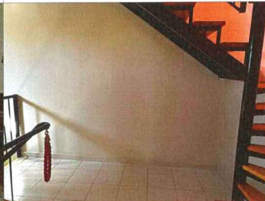
Közlekedő a tetőtérből
