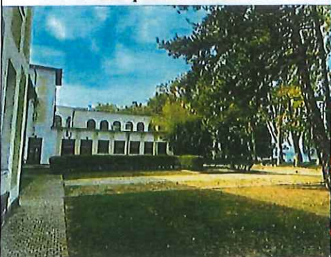
Az épület előtti terület (északi oldal)
