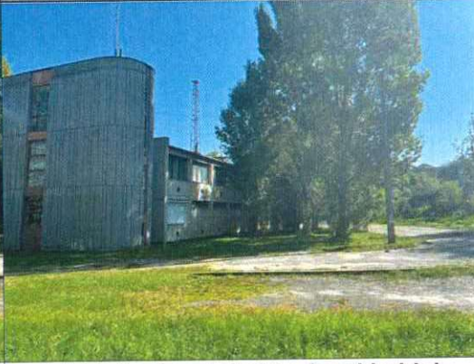
A felépítmény keleti és északi oldala
