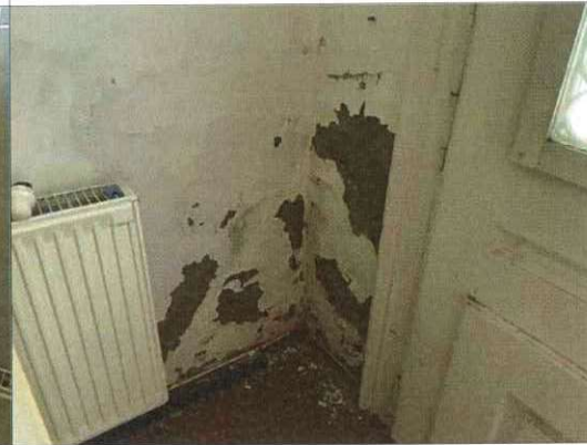
Falak vizesedésének nyomai
