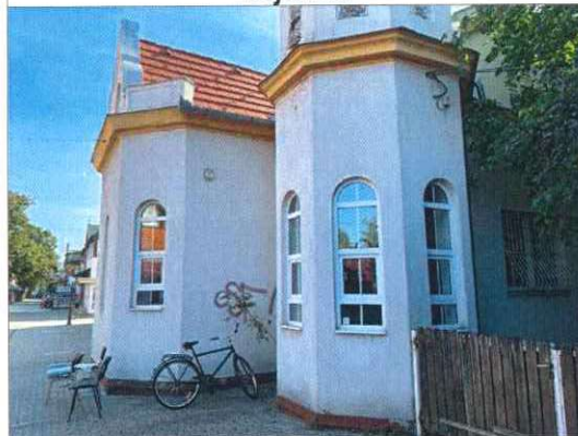
Az épület homlokzata észak-északnyugati irányból
