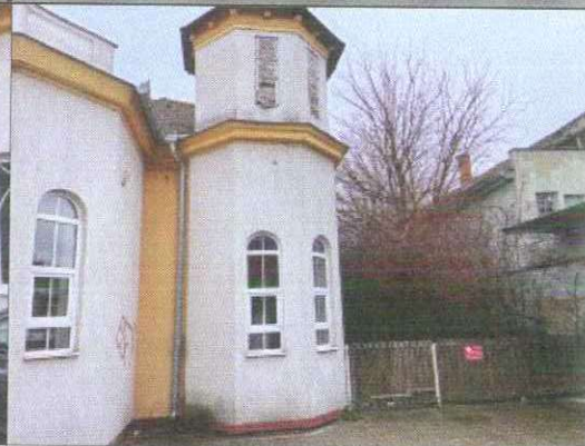
A felépítmény északi oldala
