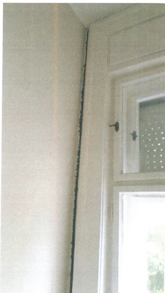
13. kép,Belső oldalon ablak mellett megjelenő repedés cm-es méret – kitöltve tömítő anyaggal rovarok ellen
