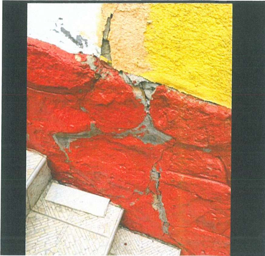
18. kép, Lábazaton rendszeresen megjelenő ferde repedés, alaptest eltörésére utal. 2022
