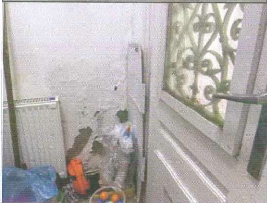
Falak vizesedésének nyomai
