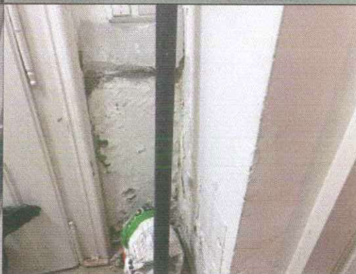
Falak vizesedésének nyomai
