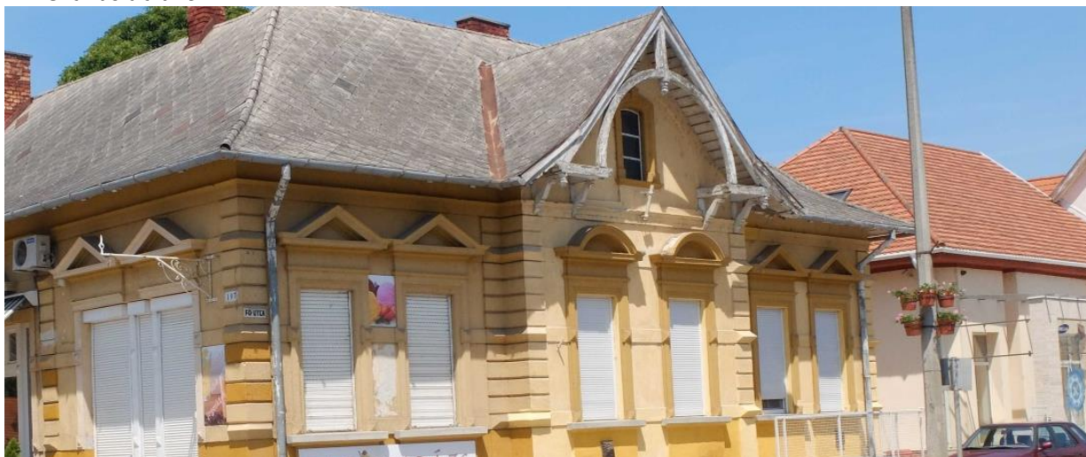
Eklektikus ablakok és homlokzati díszítőelemek
