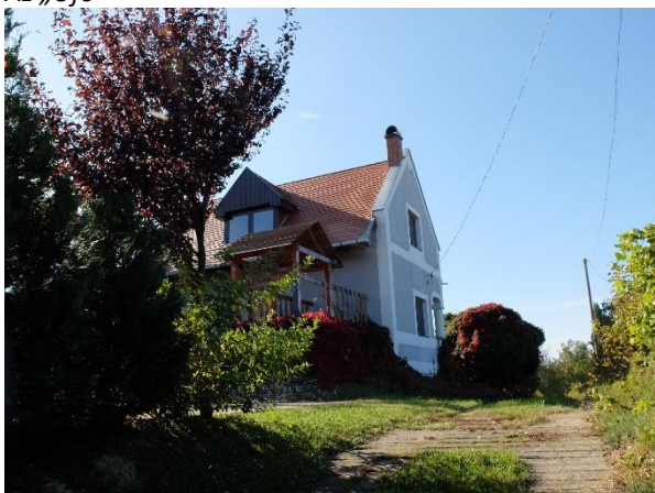
Nagyméretű tetőtér beépítéses lakó-üdülő épületek
