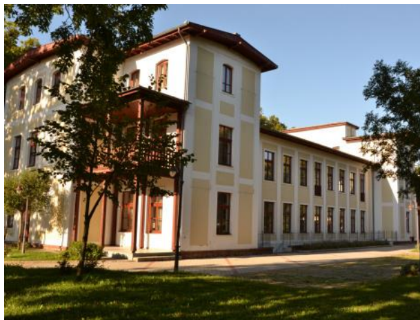
A Sió Szálló épülete 2015-ben 6
