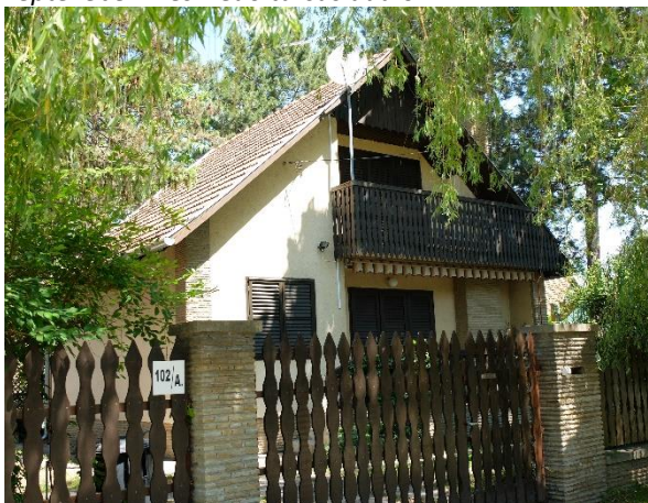
Felújított hagyományos üdülő épületek az 1980-as 1990-es évekből
