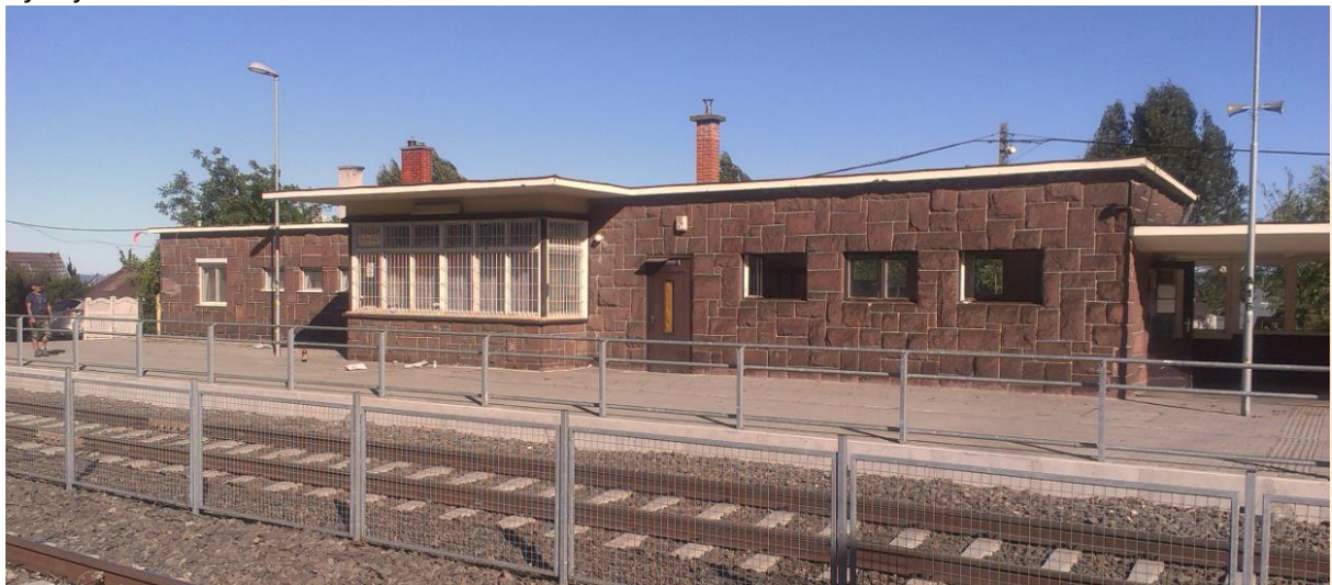
A Szabadi vasútállomás hagyományos vörös kővel burkolt épülete
