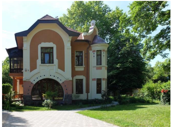
A szecessziós villaépítészet példája
