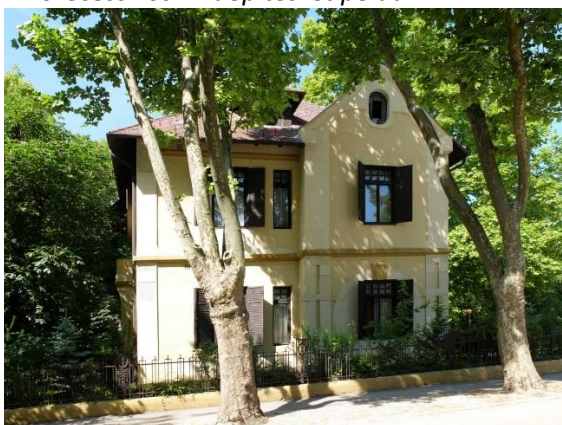
Szépen felújított villa épület
