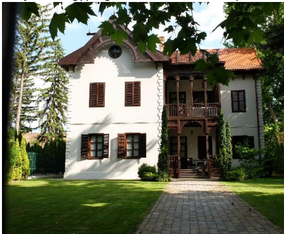
Szépén felújított svájci típusú villák szinte utolsó példái
