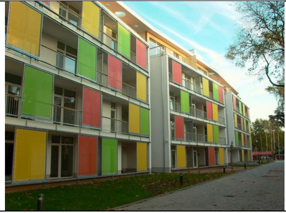
Vitorlás utca Azúr Apartmanház
